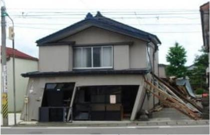
図3 地震によって損傷した住宅
